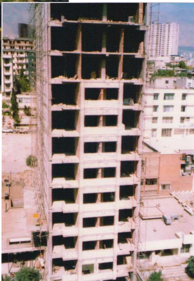
پروژه اسکلت بتنی گلشهر ۱
