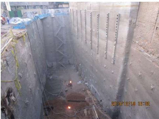
۶. عملیات پایدارسازی و مقاوم سازی گود و اجرای انواع شمع های در جا ، برجا ، برشی ، آئیند و میکروپایل و...
